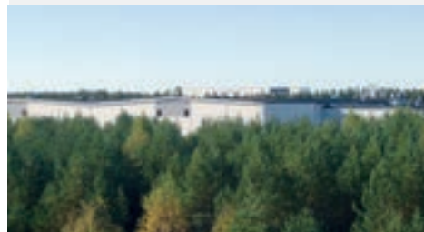
Ekman's kartong Beställare: Midroc Bygg Takarea: 2 000 m 2
