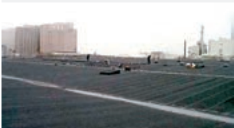
Rexam, lager Beställare: Salby Fastigheter Takarea: 3 200 m 2
