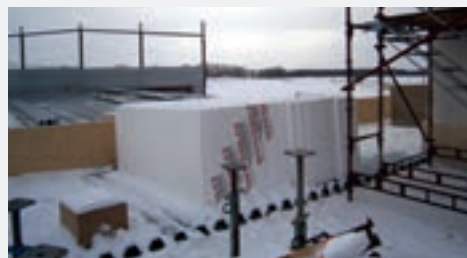
Pellviks AB Beställare: Asplunds Bygg AB Takarea: 11 800 m 2
