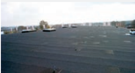
Julavaruhuset Beställare: PEAB Takarea: 40 000 m 2
