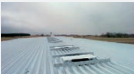
Aristo AB Beställare: Asplunds Bygg AB Takarea: 4 200 m 2
