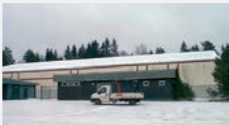
Ishallen Beställare: Tidaholms Kommun Takarea: 3 000 m 2
